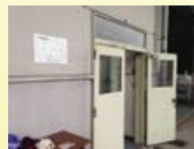
◀東大阪倉庫 1階正面入口
