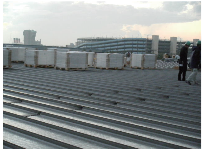
設営途中:ソーラーパネルを設置する為にレール状の棧に器具を取り付けます。
