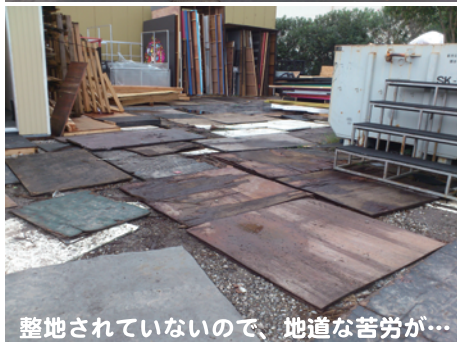
おもての処分物解体エリア
