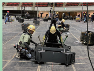
▲モーターをかけ吊り上げてから設置
